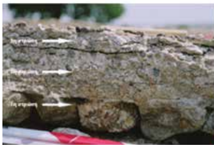
Εικ. 1. Τύποι κονιαμάτων. Α. κονίαμα δόμησης, β. επίχρισμα, γ. υπόστρωμα επιδαπέδιου ψηφιδωτού, δ. υπόστρωμα τοιχογραφίας
