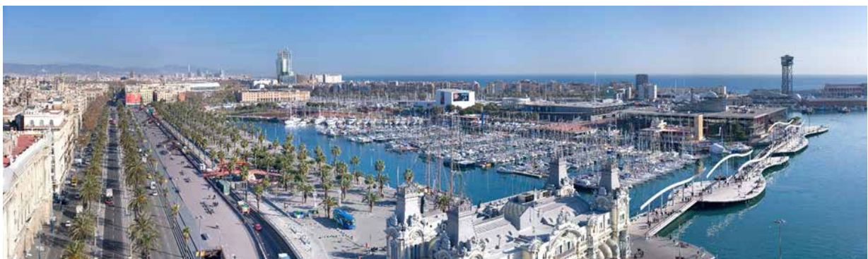
Εικ. 1. Ανάκτηση του θαλασσιού μετώπου στη Βαρκελώνη (Πηγές: google earth και https://commons.wikimedia.org/wiki/File:Port_Vell,_Barcelona,_Spain_-_Jan_2007.jpg , πρόσβαση 30 Σεπτεμβρίου 2015)
