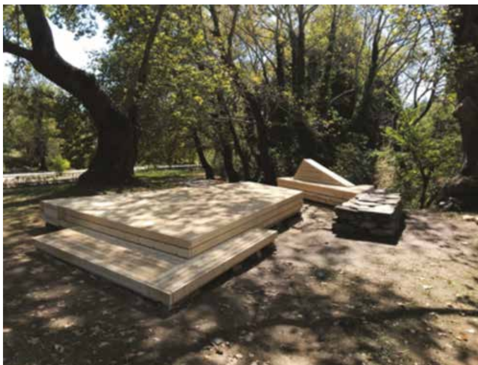
Εικ. 7. Η φάση σχεδιασμού και κατασκευής επί τόπου
