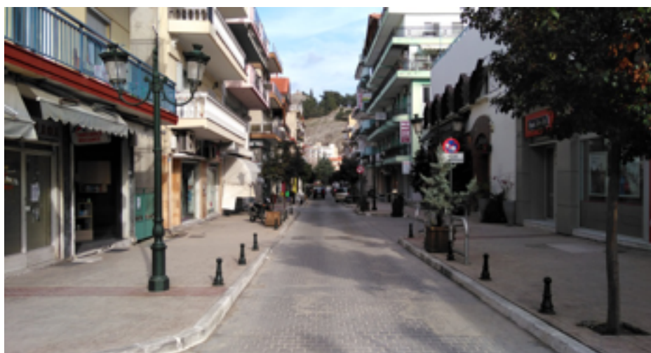
Εικ. 9: Οδός Ελ. Βενιζέλου. Μετά την μετατροπή της σε οδό ήπιας κυκλοφορίας έχει πλάτος οδοστρώματος 3,50 μέτρων (Φώτο: Αρχείο Δ.Α.)
