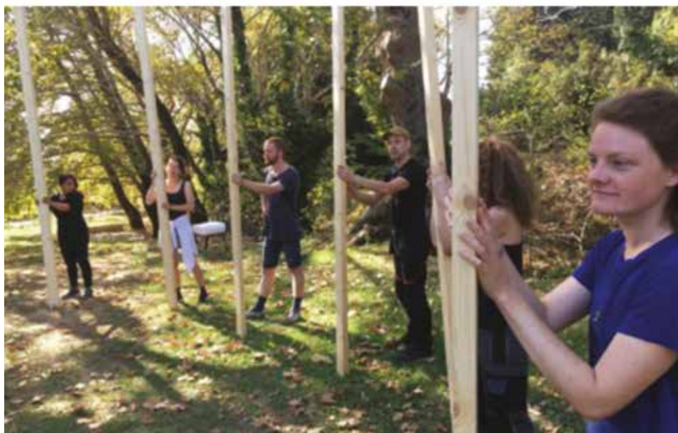
Εικ. 5. Η φάση σχεδιασμού και κατασκευής επί τόπου
