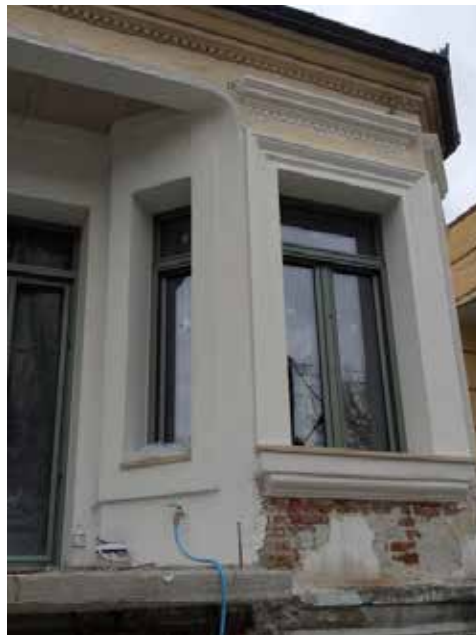
Εικ: 10: Εξωτερική άποψη της κατοικίας με περαιωμένες αρκετές από τις εργασίες. Διακρίνονται τα νέα κουφώματα (με φεγγίτες) και τα ανακατασκευασμένα πλαίσια γύρω από τα ανοίγματα.
