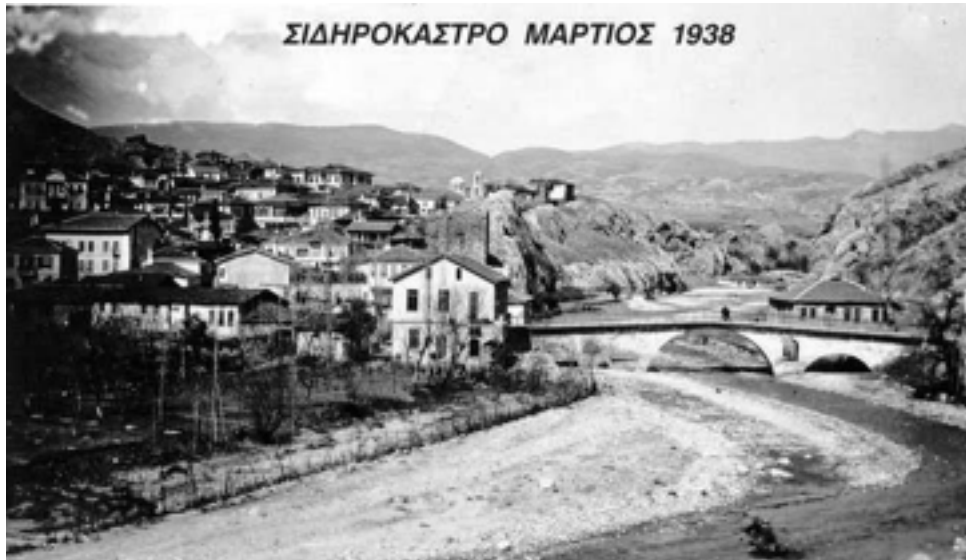
Εικ. 4: Σιδηρόκαστρο 1938. Διακρίνεται η παλιά γέφυρα του Κρουσοβίτη που ενώνει τις δύο όχθες και ο πύργος του Ανδρόνικου Γ'. Φαίνεται η αδιαμόρφωτη κοίτη του ποταμού (Πηγή: Διαδίκτυο)
