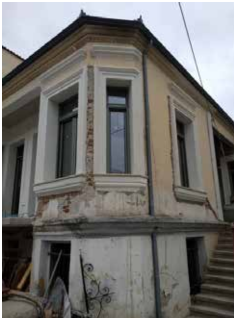
Εικ: 10: Εξωτερική άποψη της κατοικίας με περαιωμένες αρκετές από τις εργασίες. Διακρίνονται τα νέα κουφώματα (με φεγγίτες) και τα ανακατασκευασμένα πλαίσια γύρω από τα ανοίγματα.
