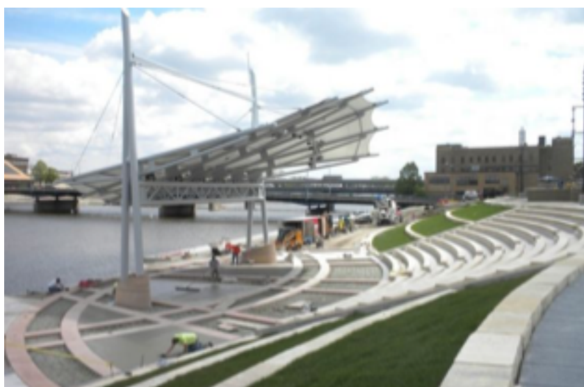
Εικ. 22: Άποψη ανοικτού αμφιθεάτρου δίπλα σε όχθη
