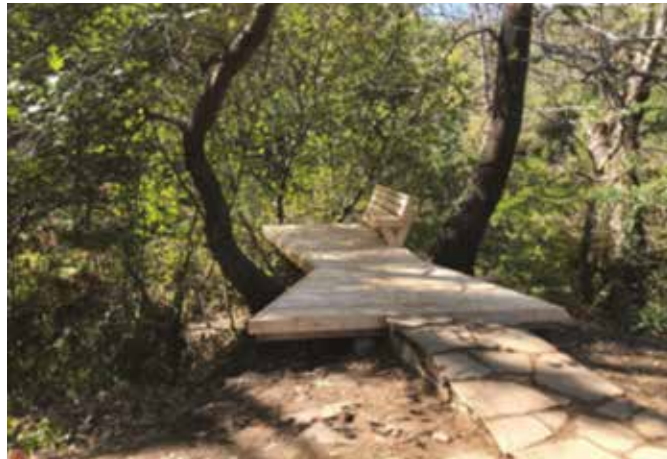
Εικ. 9. Η φάση σχεδιασμού και κατασκευής επί τόπου
