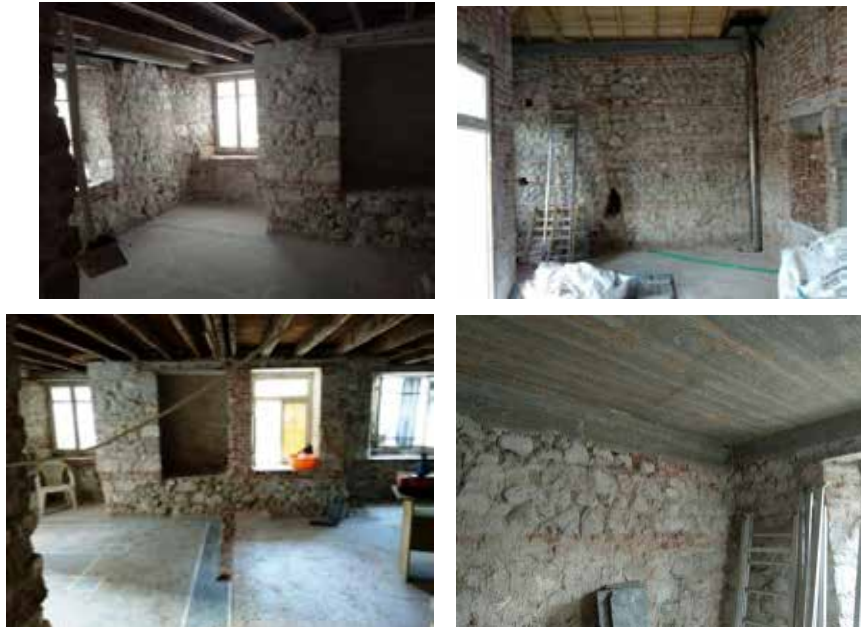
Εικ. 6: Εσωτερική άποψη του εμπρός τμήματος του υπογείου και του ορόφου πριν τις εργασίες. Διακρίνεται ο παλιός διαχωριστικός τοίχος και το μωσαϊκό δάπεδο. Το πάτωμα από οπλισμένο σκυρόδεμα. Διακρίνονται κάποιες ρηγματώσεις που επιδιορθώθηκαν με τα κατάλληλα υλικά.
