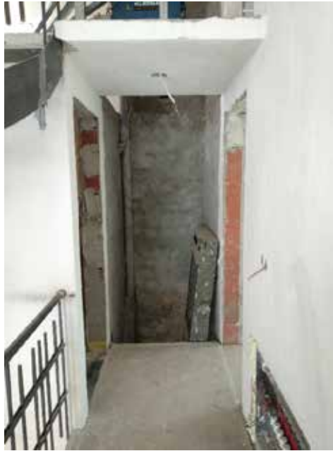
Εικ. 9: Άποψη του χώρου όπου θα τοποθετηθεί ο ανεγκυστήρας.
